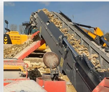
Material de tamaño excesivo que se devuelve a la cámara
