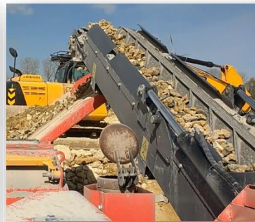
Rückführung von Überkorn in die Brechkammer
